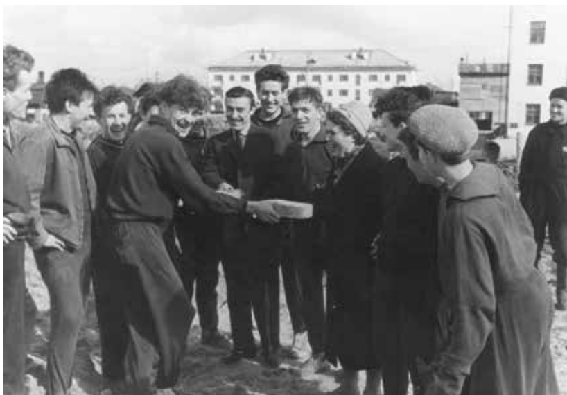
Студенческие годы Е. С. Куликова. Строительство спортзала
